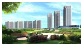
4. Комплексная жилая застройка Застройщик – ИНЭКС Площадь – 250 000 м 2 Дата ввода – 2024 – 2025 гг.
